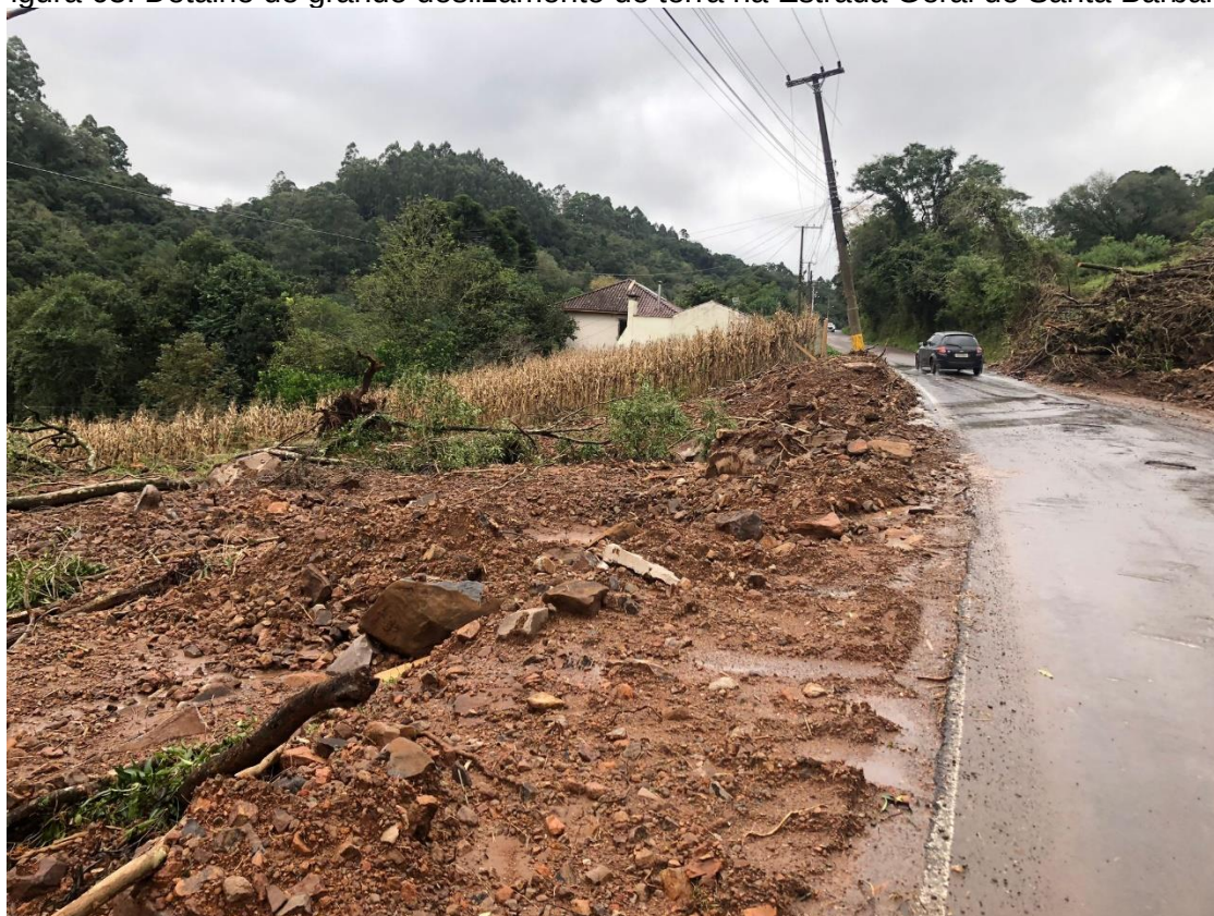
Figura 63: Detalhe de grande deslizamento de terra na Estrada Geral de Santa Bárbara.
