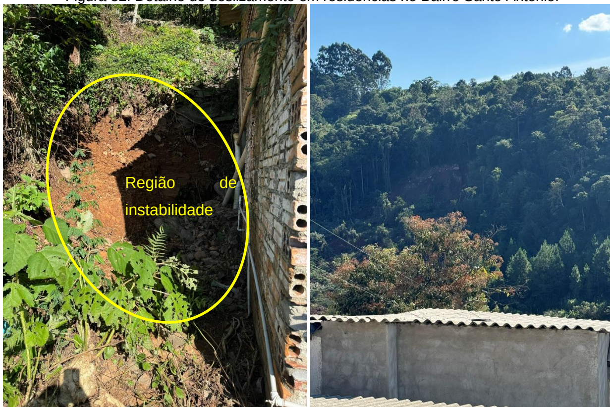
Figura 32: Detalhe de deslizamento em residências no Bairro Santo Antônio.
