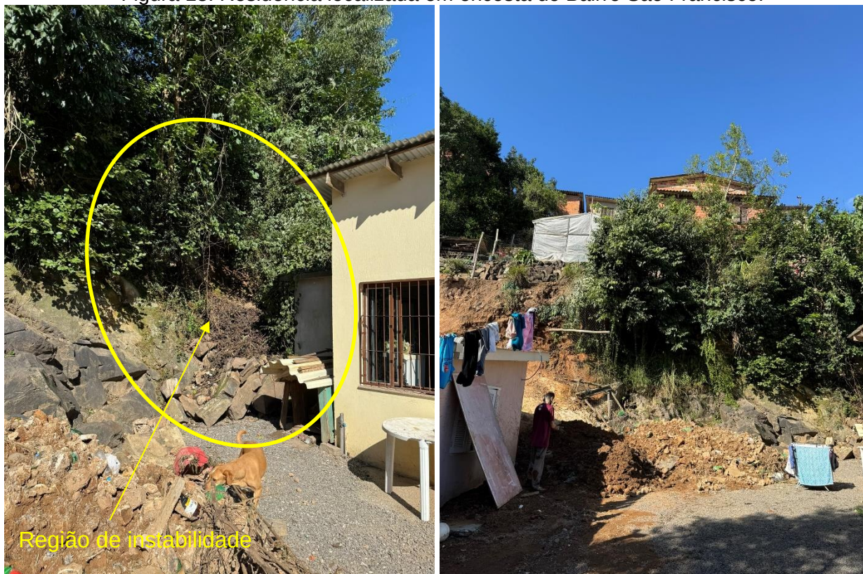
Figura 18: Residência localizada em encosta do Bairro São Francisco.
