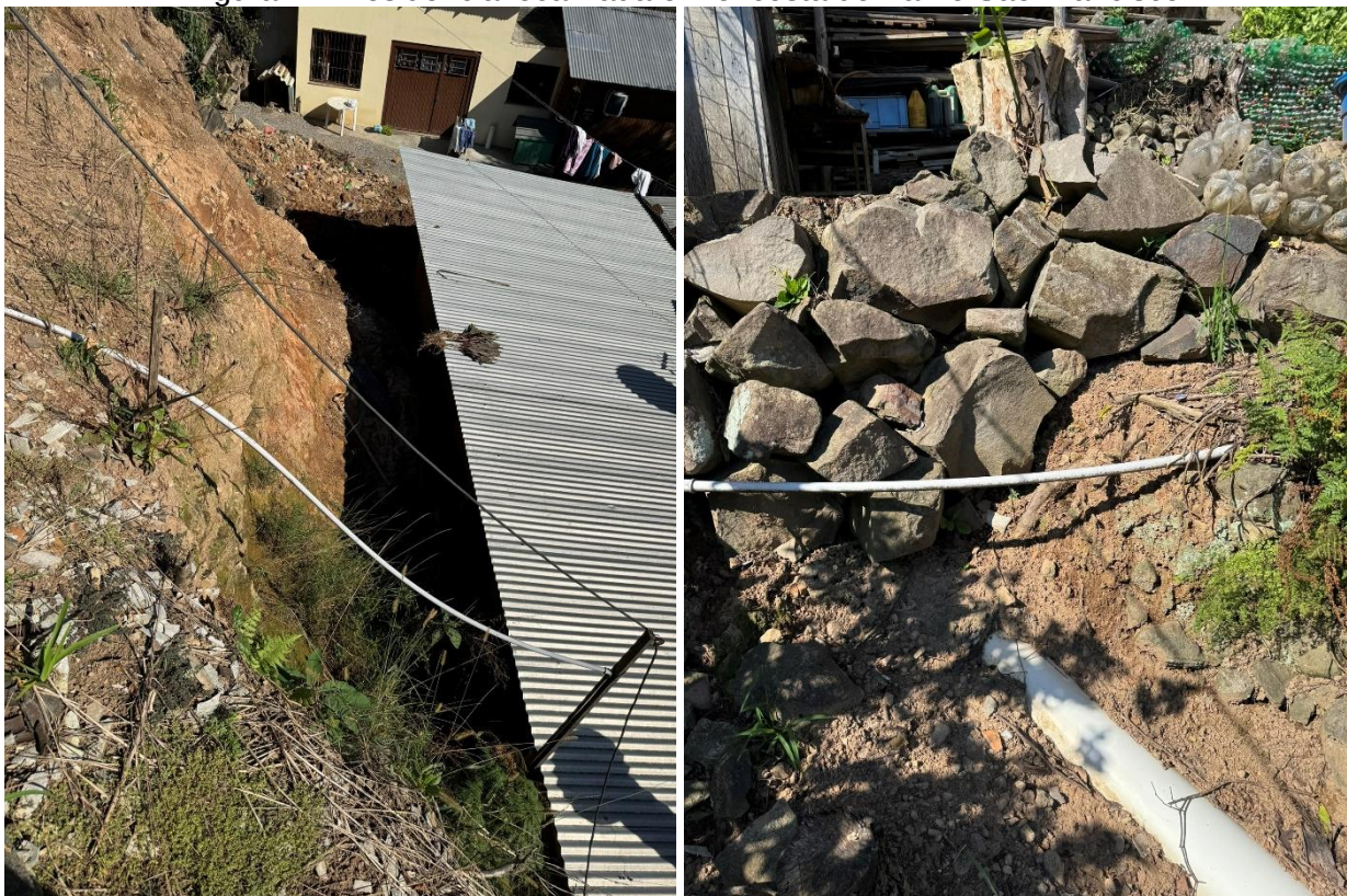
Figura 21: Residência localizada em encosta do Bairro São Francisco.
