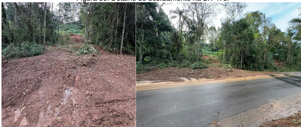
Figura 50: Detalhe de deslizamento na BR 470.
