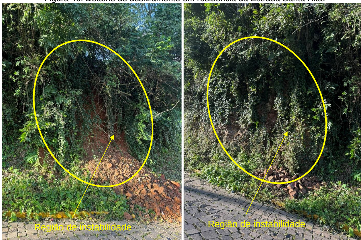
Figura 40: Detalhe de deslizamento em residência da Estrada Santa Rita.
