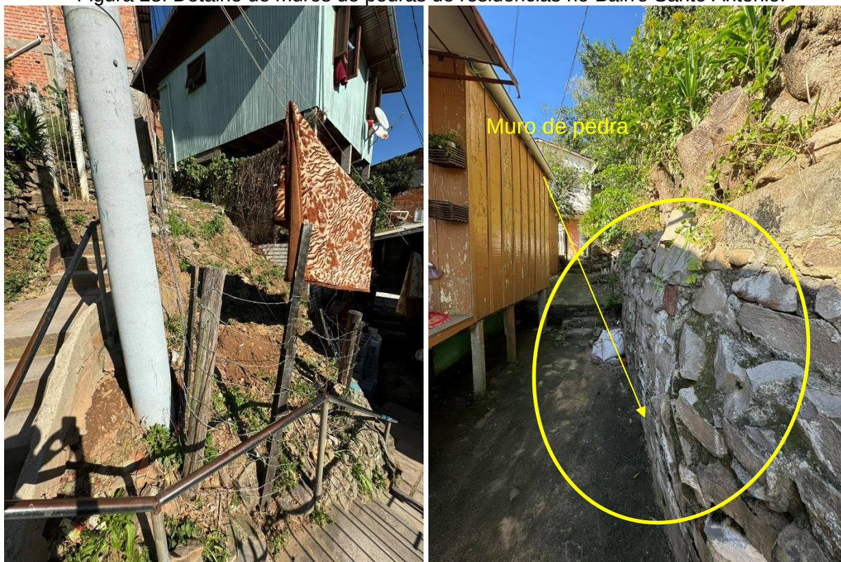
Figura 28: Detalhe de muros de pedras de residências no Bairro Santo Antônio.
