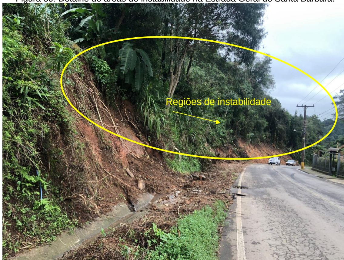
Figura 59: Detalhe de áreas de instabilidade na Estrada Geral de Santa Bárbara.
