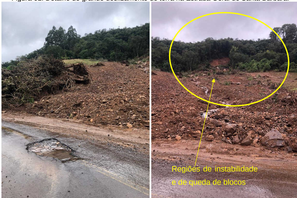
Figura 61: Detalhe de grande deslizamento de terra na Estrada Geral de Santa Bárbara.
