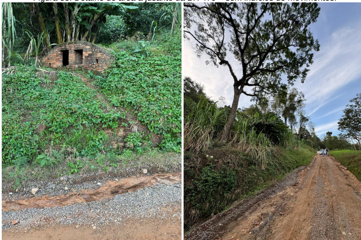
Figura 55: Detalhe de área a jusante da BR 470 – sem indícios de movimentos.
