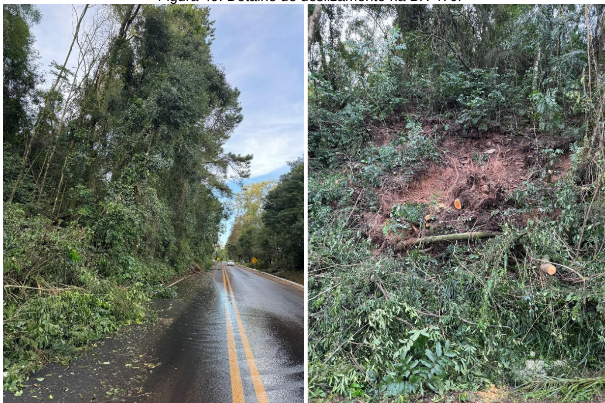
Figura 49: Detalhe de deslizamento na BR 470.
