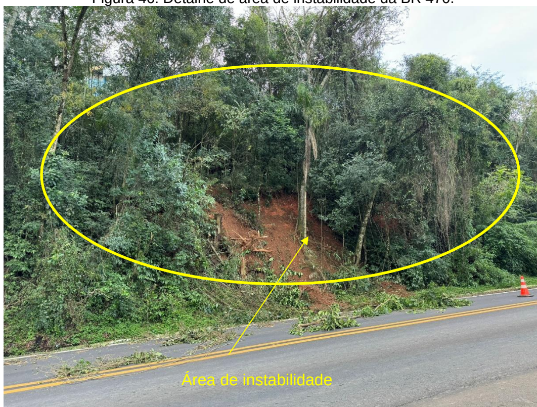
Figura 46: Detalhe de área de instabilidade da BR 470.
