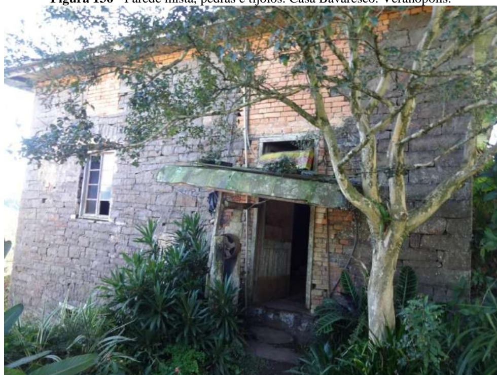
Figura 136 - Parede mista, pedras e tijolos. Casa Bavaresco. Veranópolis.
